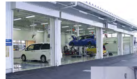
トリプルテスター、固定式フリーローラーを設備した検査ライン
