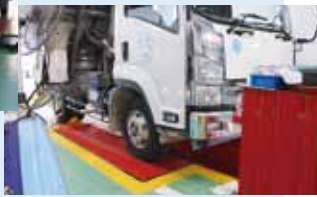
タイヤリフトで2軸車のミッション脱着も容易に
