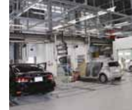
給気ファン、コンプレッサーは 中二階に設置、消火設備も完備
