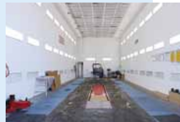
建屋一体型の塗装ブース。防爆仕様のスーパーツインエースを設備
