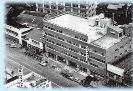
1983(昭和58)年に増築した5階建ての本社
