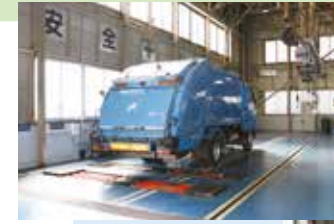
ブレーキ・スピードメーターテスター、フリーローラーを設備した検査ライン
