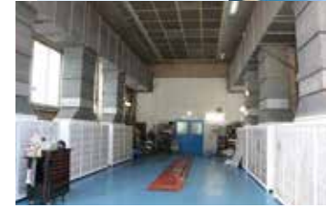
建屋一体型の塗装ブース
