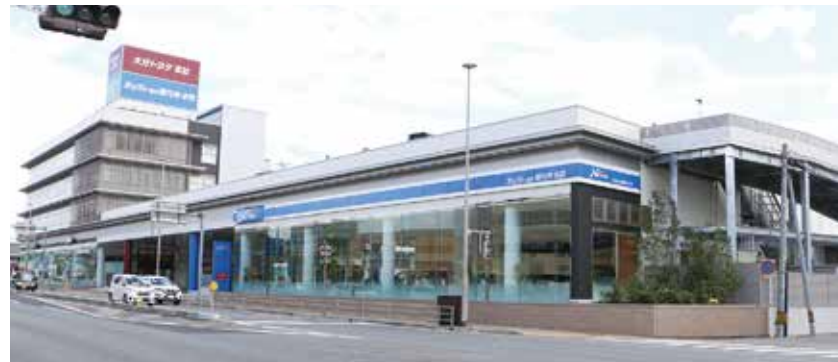
国道10号線に面した新店舗外観。奥側が大分トヨタ本店
