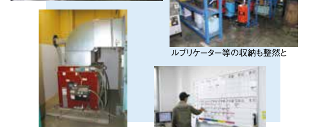
廃油燃料のクリーンバーンヒーターを2基設備し、厳冬期も暖か。20kl廃油タンクを埋設
