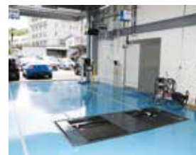
集中給油、廃油回収が行えるオイルサーバーを2か所に設備
