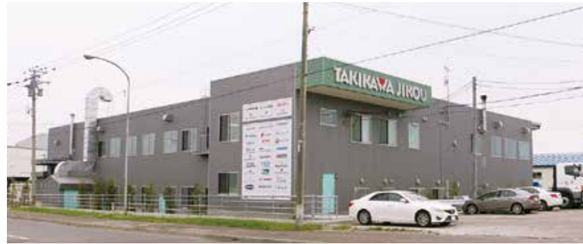
道路側から見た工場外観、ダクトは切替式換気装置の排気用
