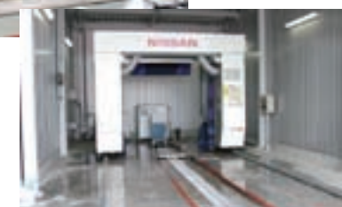
洗車場には門型洗車機と自動下部洗浄機を併設
