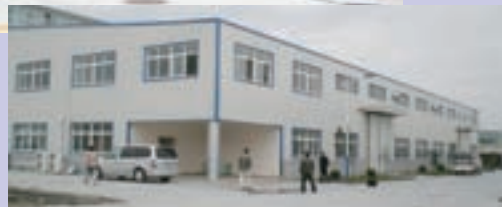
竣工前の工場の外観
