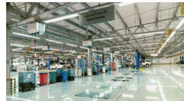
明るく清潔なサービス工場、設備機器もスッキリと配置
