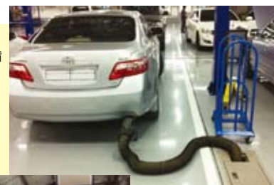
全ストールの床面に 排気ガスのダクトを設備
