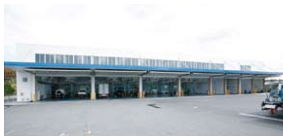
整備ストール、検査ラインなど、計12ストール
