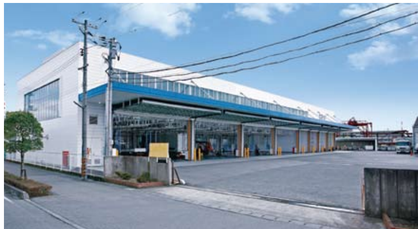
水島コンビナートへ向かう幹線道路に面した立地
