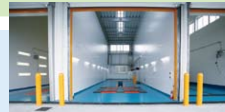
全自動式ヘッドライトテスター等を備える検査ライン
