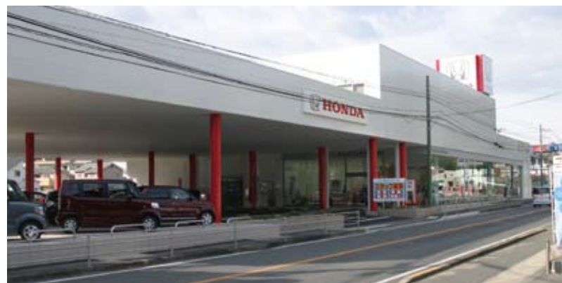
諫早方面に向かう国道34号線に面した店舗の外観
