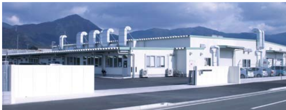
粕屋総合センターの外観、約460台分の駐車スペースを擁する
