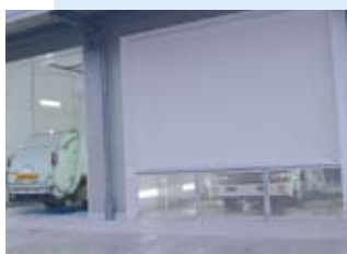
右側塗装ブースは自然給気の横引き方式
