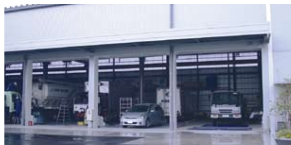
完成後の品質をチェックするため検査ラインを完備
