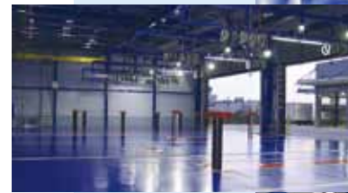
天井走行クレーンも東西に各1基、すべてのストールをカバー。
