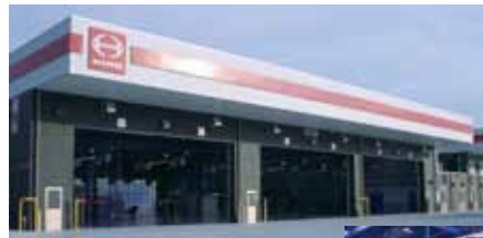
工場西側の6ストール、手前が車検整備、奥側が一般整備。
