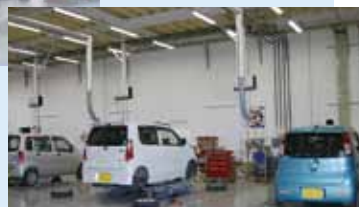
各ストールにエアコンダクトを設備、照明はLEDで明るく
