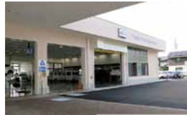
中央通路にはスピードシャッターを設備
