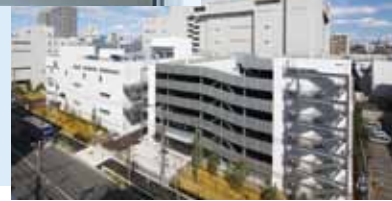
工場全景。右側の立体駐車場とブリッジで各フロアに直結
