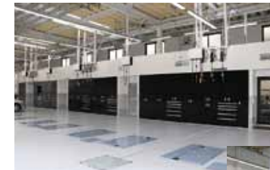
タンデムリフトを設備した小型車整備ストール。エアコンダクトも壁内に設置。
