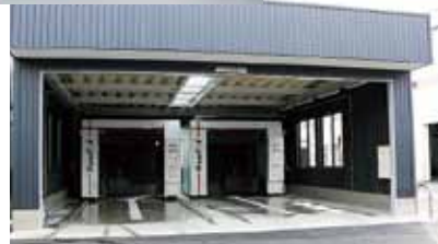
門型洗車機を2台設備した洗車棟。
