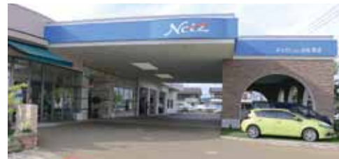
店舗のエントランス。アーチの中はお客様駐車場
