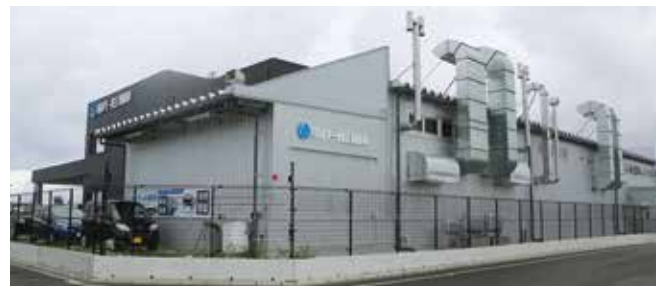
ブースダクトと床面吸塵装置のダクトが並ぶ
