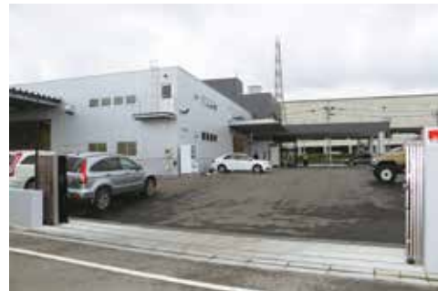
敷地奥からもアクセス可能。屋上は災害時の避難にも対応
