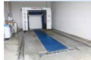
滑りにくく水はねを防止するFRPグレー チングを採用。門型洗車機と固定式下部 洗浄機で洗車作業を省力化
