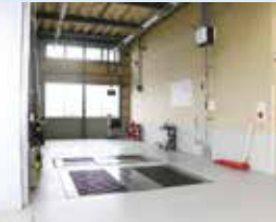
検査ライン。トリプルテスター、固定式フリーローラーを設備
