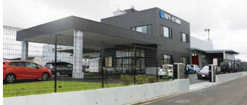
社屋・工場の外観。敷地は1.6m高くかさ上げしている
