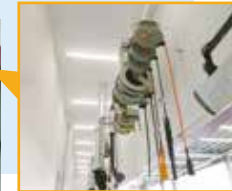
リール、冷暖房も下り壁の裏に 設置
