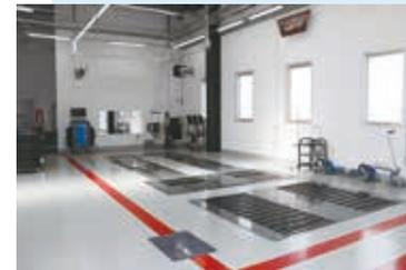
認証工場ながら完成検査場を完備、ストールごとに埋設式排気ユニットを設備
