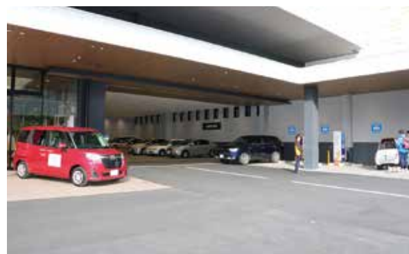
店舗・工場入口。お客様駐車場も雨天時を考慮し屋内に
