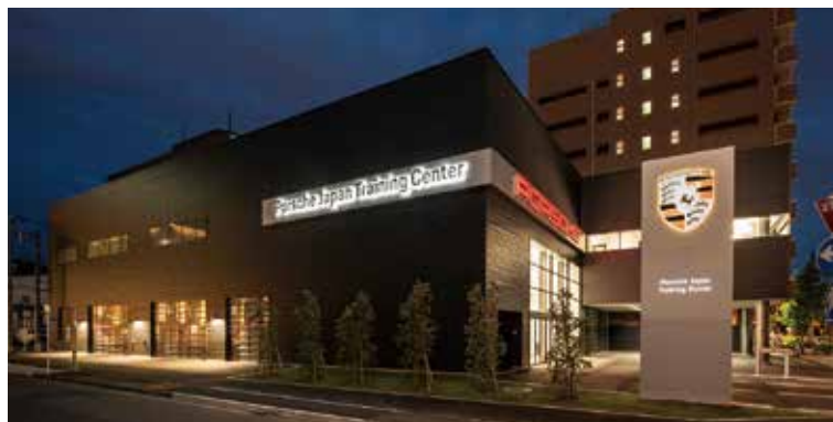
環状2号線に面したトレーニングセンター外観
