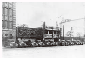
エンパイヤ自動車商会のフォード車ショールーム。通り抜けのアーケードになっており、部品部、事務所、寮なども入っていた。現在の八重洲ファーストフィナンシャルビルのある場所である。
