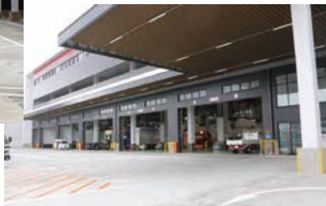
1階サービス工場の外観、写真奥が洗車場と検査ライン
