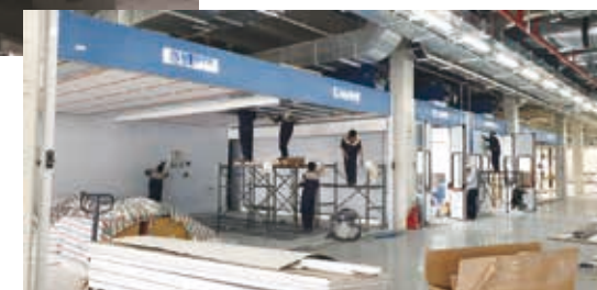
塗装ブースの施工
