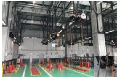
左端の2ストールに キャタピラツイーンエース2基
