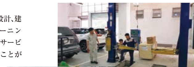
リフトの据付け
