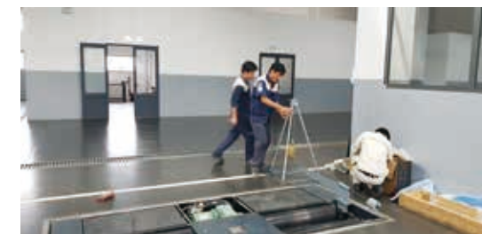
検査ラインの施工
