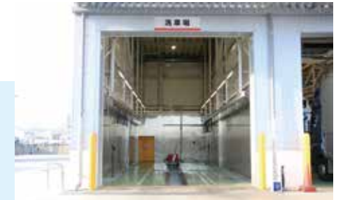
洗車場はステンレス鋼板を張り、明るく清潔な環境に。
