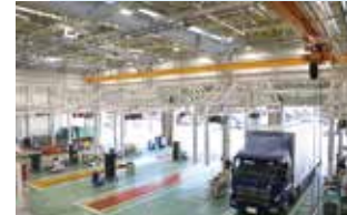
天井クレーンは一般・重整備の4ストールをカバー。
