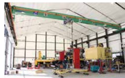
天井クレーンは全てのストールをカバー。
