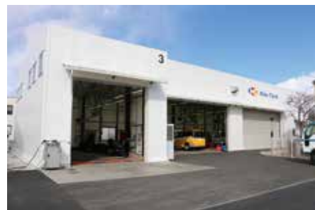
第3工場はオーバースライダーシャッターを採用、屋根は二重構造で断熱性も確保。
