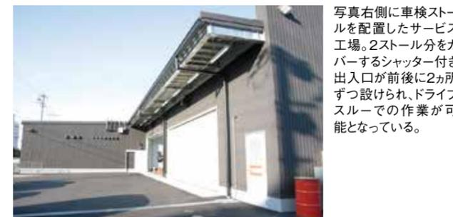
写真右側に車検ストールを配置したサービス工場。2ストール分をカバーするシャッター付き出入口が前後に2ヵ所ずつ設けられ、ドライブスルーでの作業が可能となっている。
