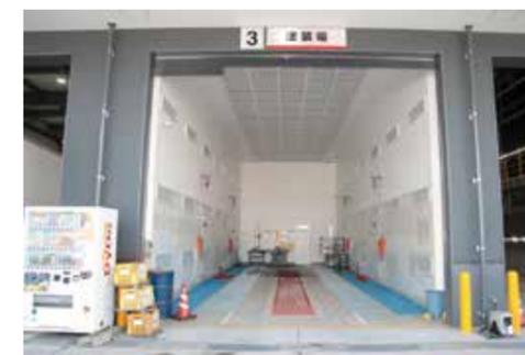
建屋一体型の「塗装場」。「ツインエース」はシンダーへのミスト対策として伸縮保護カバーが装着された特注防爆仕様
