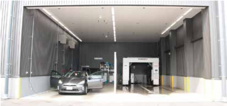
洗車場には 2 つのサービス工場を隔てる通路からアクセス。門型洗車機「エミネントデルタⅡ」で洗った車両は隣のスペースで拭き上げる。
