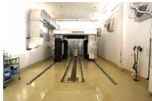
門型洗車機、エミネントレボリューション。雪国のため、もちろん下部洗も設置。
