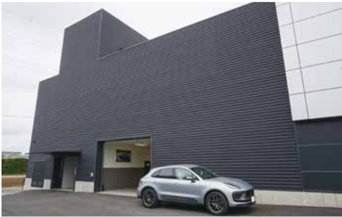
ワークショップ外観。入口にエアカーテンを設備し、気密性を向上。
