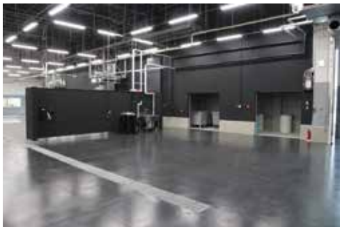
サービス工場内の洗車場には隔壁を設けて水滴などの飛散と騒音の拡散を防止。門型洗車機「エミメントαⅣ」で洗った車両は普通充電器も備わる向かいのスペースで拭き上げる。
