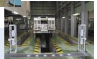
固定式下部洗浄機と側面洗浄機を装備した洗車場、ステンレス張りですつねに清潔
