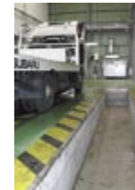
補助洗いが立ったままで行なえるよう、両側にピットを設けている
