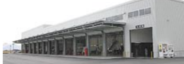
整備10ストールと車体2ストール、洗車場も併設した大型車工場
