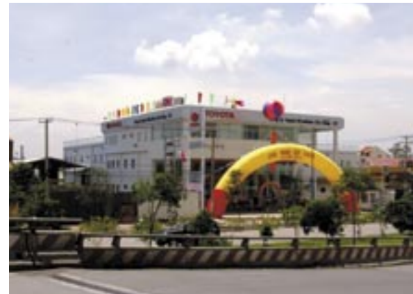
トヨタ・ヒロシマ・タンカン 自動車サービスセンターの外観
