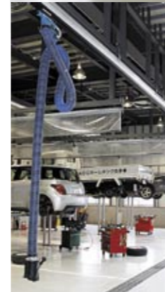
すべてのストールに移動式の排気ガスリールを設備
