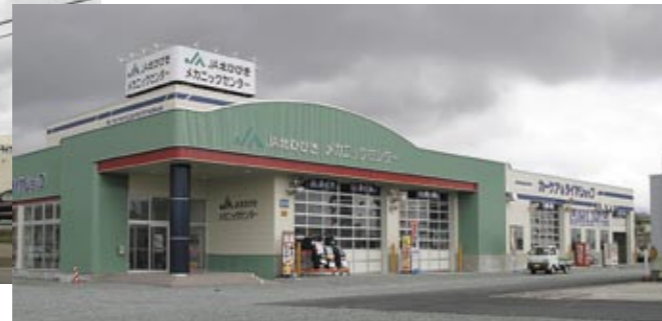
メカニックセンターの外観、延床面積約1300㎡
