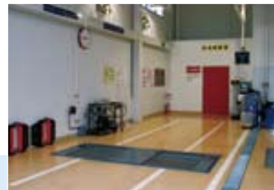
完成検査ライン、トリプルテスターは 設置スペースもコンパクト
