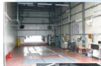
検査ラインにはネットワークシステムを2店舗の切り替え式として導入
