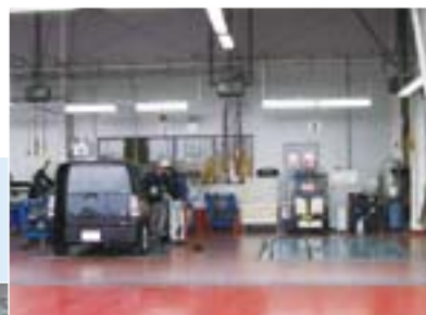
照明は段差を付けた「ぶどう棚式」に配置され、明るさと省エネを実現
