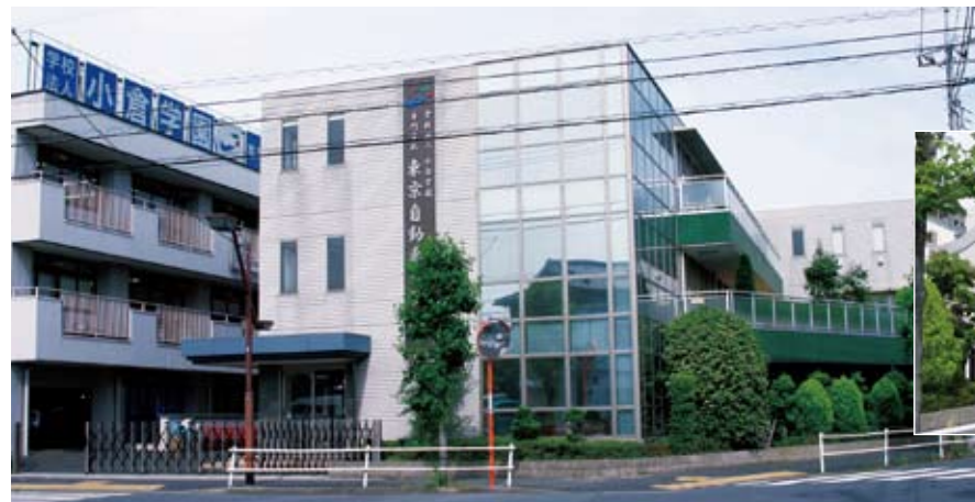
新設されたボディクラフト科、4号館の外観
