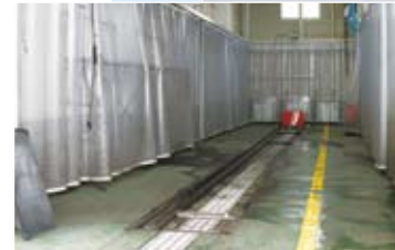
自動下部洗浄装置で洗車作業を省力化
