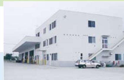
新整備工場は駐車スペースも広大、入出庫にも余裕の広さ
