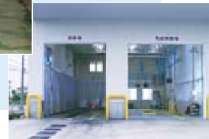
洗車場(左)完成検査場(右)
