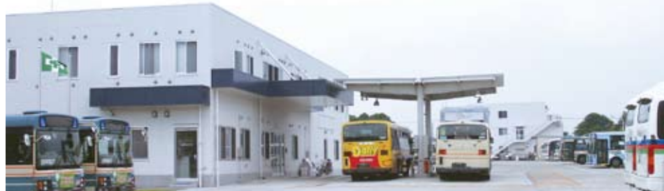
所沢営業所(左)と整備工場(中央奥)の外観
