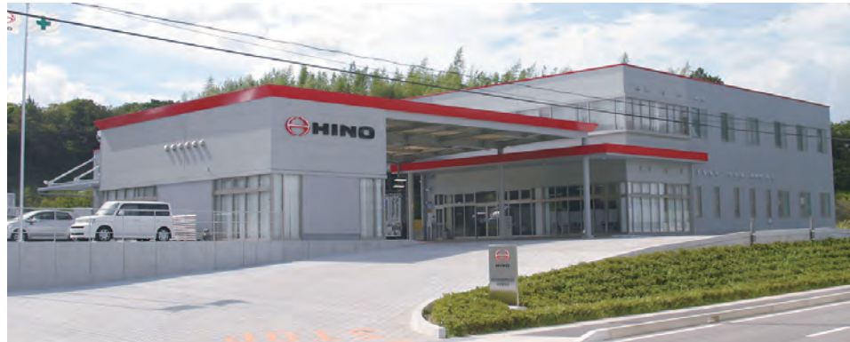
各務原市郊外の産業団地「テクノプラザ」に完成した新店舗・サービス工場
