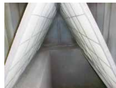
汚れた排気フィルター
