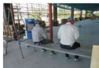
建築現場で使用
