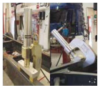
フランジ面局部曲がり修正(20t)
