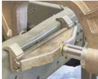
フランジ面局部曲がり修正 (40t)
